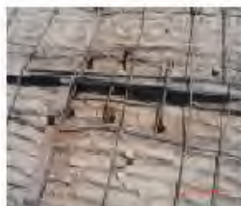
یکپارچه کردن سقف با استفاده از شبکه های فلزی
